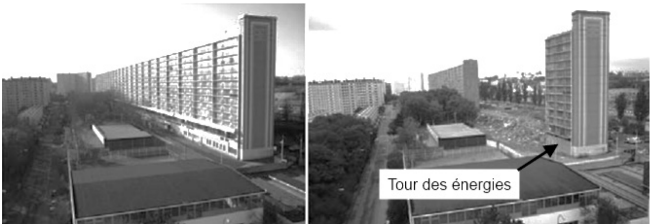
fig. 2: le Cèdre Bleu avant et après démolition partielle (courant 2009)
