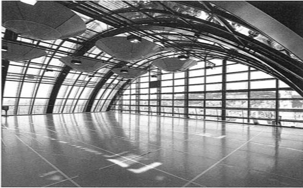
Figure 5 : La structure métallique de la grande salle de répétition ( www.opera-lyon.com ).
