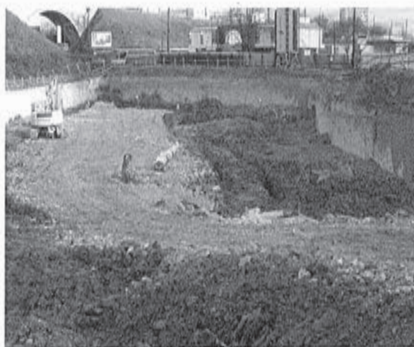
figure 24 Fouille et rampe du chantier
