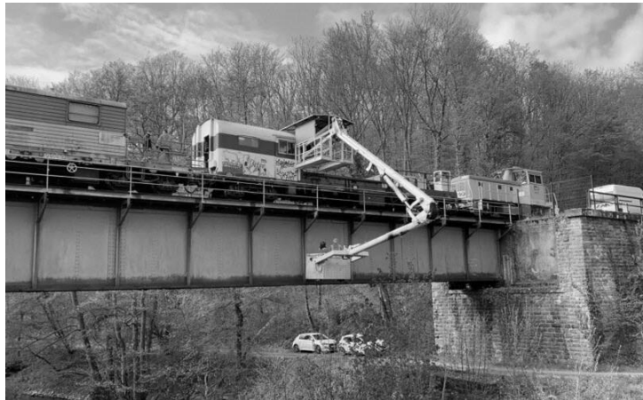
Figure 1 contrôle d'ouvrage par nacelle traditionnelle
