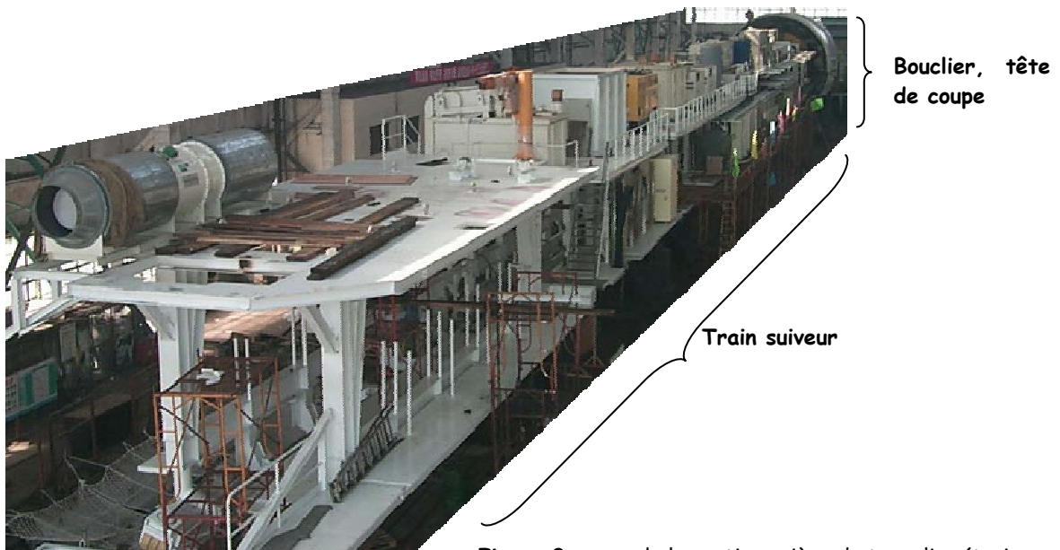
Figure 2 : vue de la partie arrière du tunnelier (train suiveur) en cours de construction
