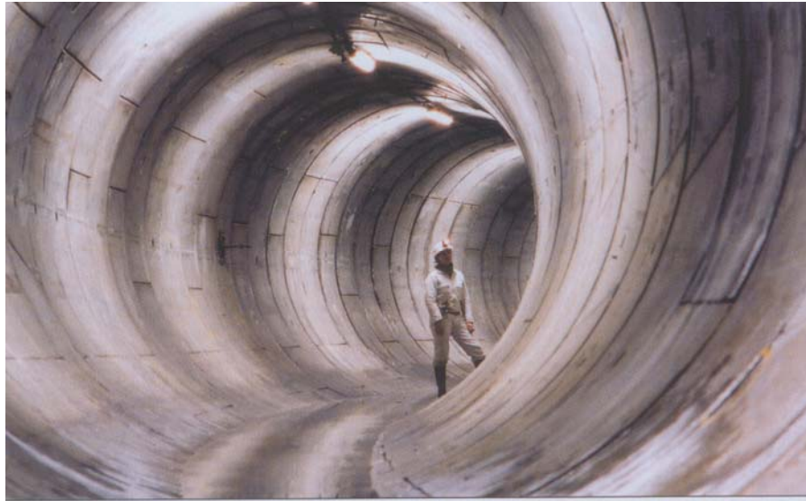
Figure 3 : aspect d'une galerie de tunnel réalisée par anneaux de voussoirs
