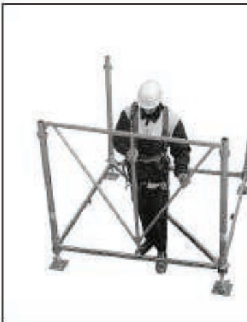
5 Pose de l'étage courant supérieur.
