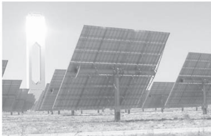
Figure N°1 : vue du champ d'héliostats et de la tour de la centrale PS10
