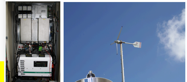
(c) Convertisseurs statiques : onduleur et hacheurs MPPT
