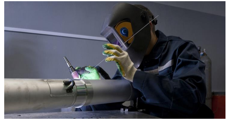
Soudage TIG d'un tuyau d'aluminium
